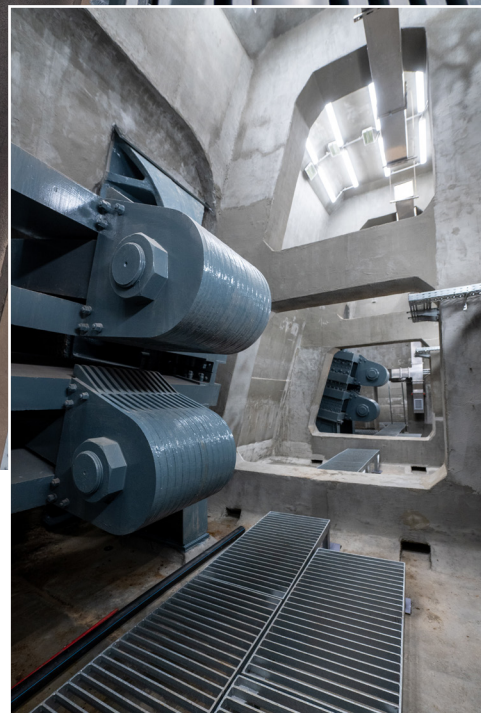
Lánchíd belső szerkezetének korrózióvédelme
